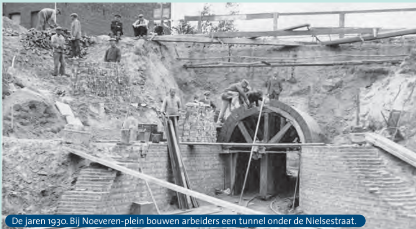
De jaren 1930. Bij Noeveren-plein bouwen arbeiders een tunnel onder de Nielsestraat.
