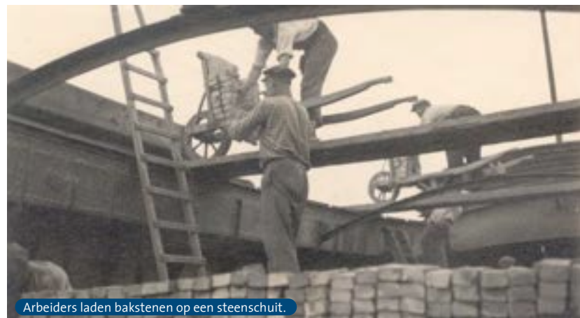
Arbeiders laden bakstenen op een steenschuif.
