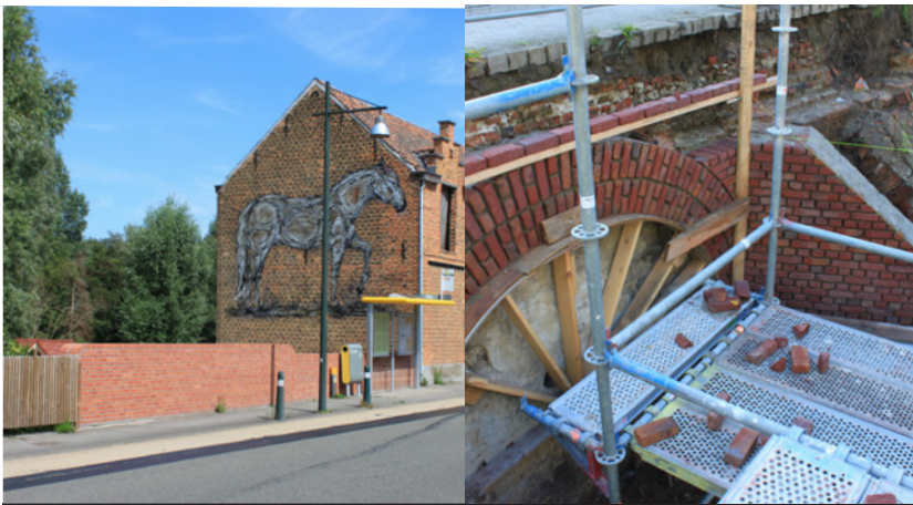
Restauratie tunnelmond en tunnelmuur (met zicht op straatzijde paardenstal), foto HVR
